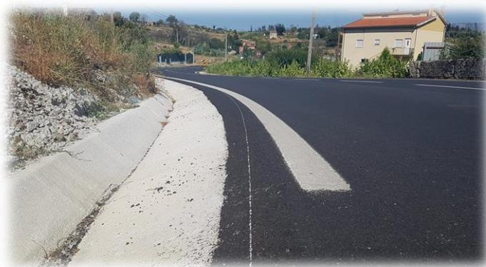
A obra integrou também a execução de dois passeios, dando continuidade aos passeios já existentes na Avenida dos Olivais, bem como melhorias ao nível da drenagem de águas pluviais.
