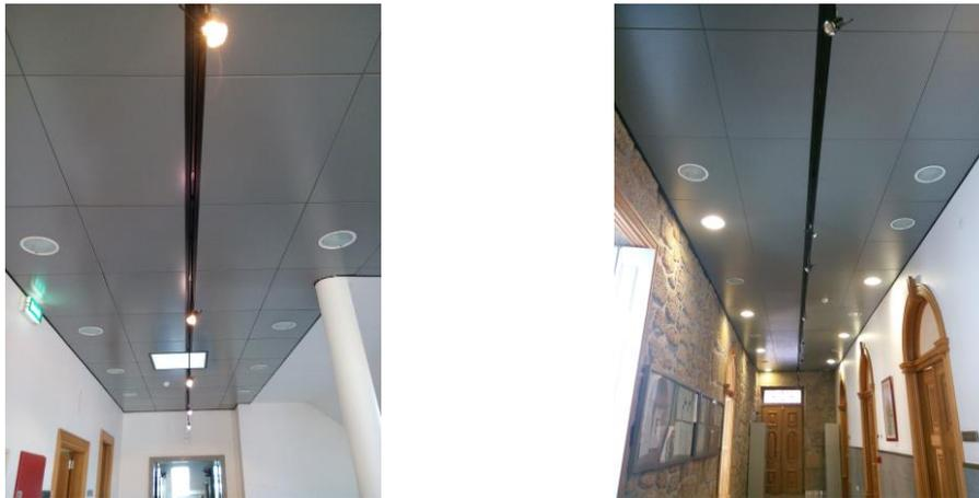
**Figura 2 - Lâmpadas de halogénio (esquerda) e Lâmpadas fluorescentes compactas desligadas em quincôncio (direita)**
