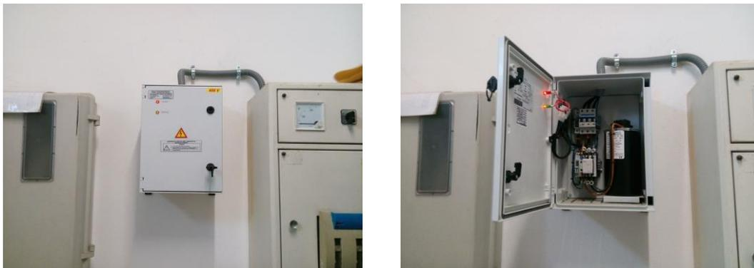
**Figura 3 - Bateria de condensadores instalada no PT do edifício dos Paços do Município**
